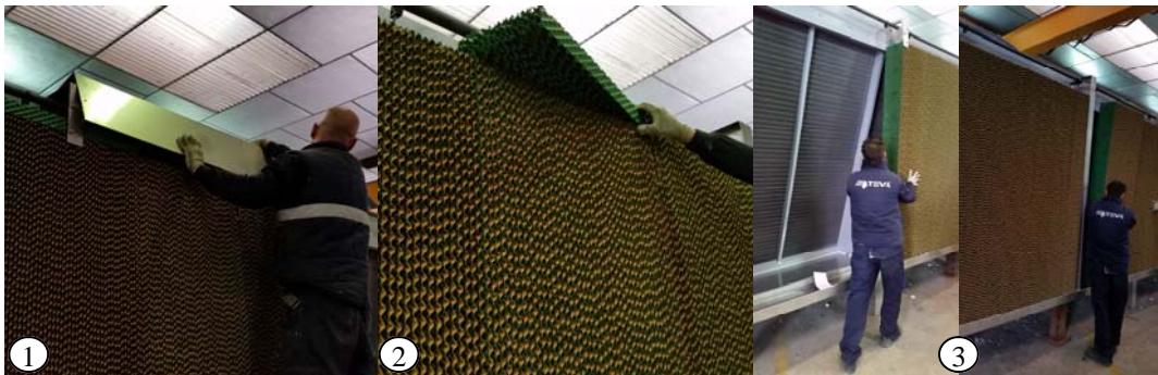
Sustitución del panel de preenfriamiento / Precooling adiabatic panel replacement
